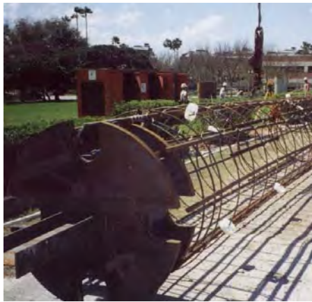
Одноуровневая кольцевая ячейка, готовая к установке
