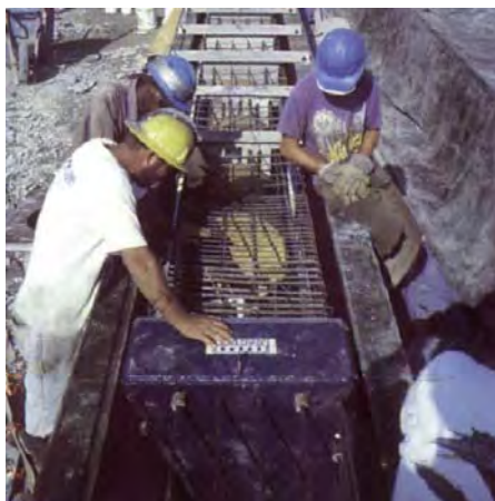
Установка О-селл в предварительно залитую сваю
