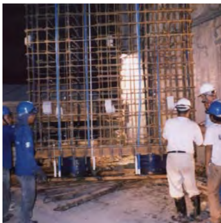
Установка О-селл в скважину с буровым раствором
